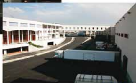
WÜRTH ESPAÑA, S.A. TOLEDO. CENTRO DE DISTRIBUCIÓN Y OFICINAS. 12 000m 2 Torrella Ingenieros
