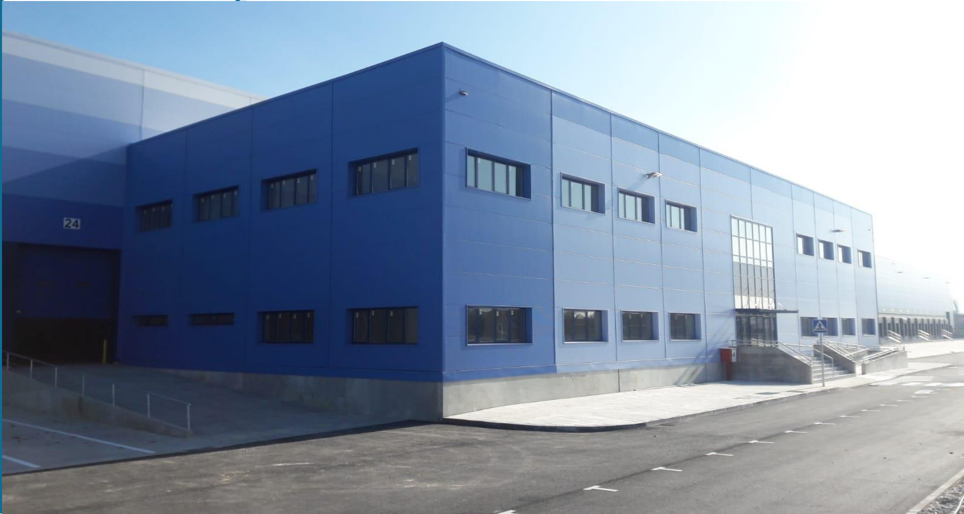
NAVE LOGITICA P.I DEL HENARES
